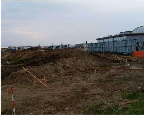
羽田空港跡地の造成工事状況 (9月17日)
